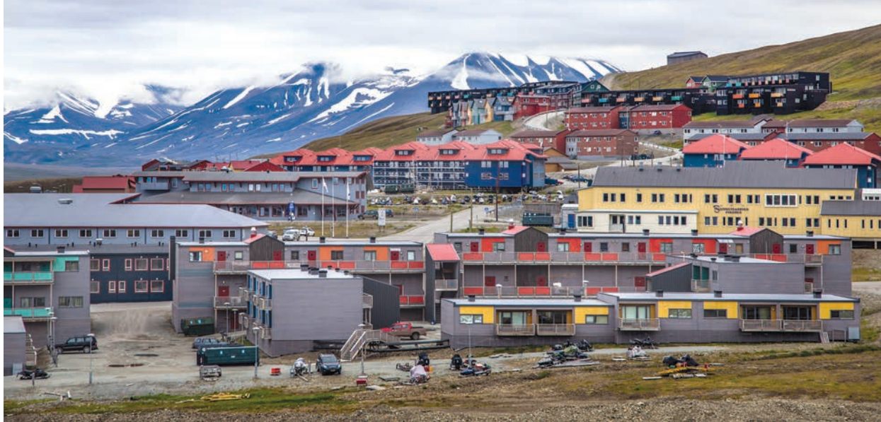
Fot. 1. Widok miasta Longyearbyen z widoczną zabudową doliny Gruvedalen w tle. fot. Agnieszka Żabicka, 2016 Photo 1. View of Longyearbyen with the development of Gruvedalen Valley in the background. Photo by Agnieszka Żabicka, 2016
